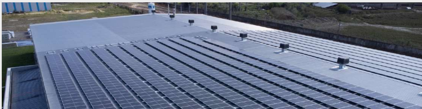
Structura din profile zincate pentru panouri fotovoltaice _ Montaj pe acoperis _ Hala productie Proinvest Group
